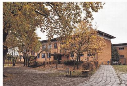
Die Theodor-Körner-Schule in Picher ist stark sanierungsbedürftig. Der Schulzweckverband als Träger will deshalb ein neues Schulgebäude errichten lassen und dieses Jahr 300 000 Euro für die Planung ausgeben. Foto: role
